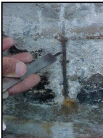
**Foto 1 – Armadura corroída em viga de marquise**
